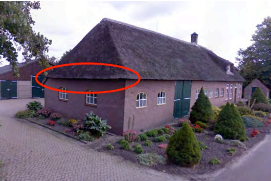
Afbeelding 6: Locatie huismusnest onder de rieten kap op achtergevel van de boerderij binnen het plangebied, rood omcirkeld. Bron foto: Google Earth Street View.
